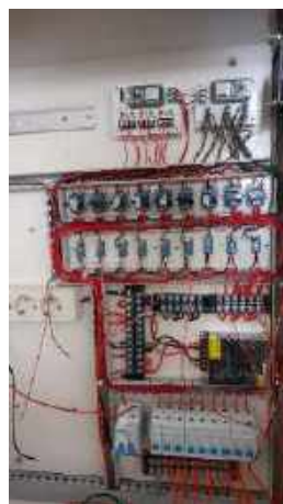
Gambar 3. 16 Proses Pengkabelan Pada Komponen
